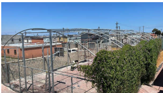
Januar 2023: Bauarbeiten Dachkonstruktion
