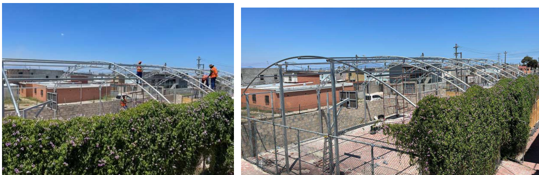
Januar 2023: Bauarbeiten an der Dachkonstruktion
